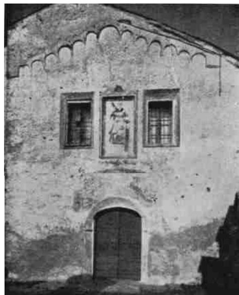
Fig. 11 Facciata di San Vincenzo in Castro prima delle opere di restauro 1965-1968 - da "Architettura romanica nel Novarese" a cura prof. arch. P. Verzone
