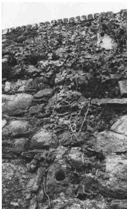
Fig. 19 Tubazione idrica (fistula) rinvenuta nel muro di contenimento del parco di palazzo De Visart che fiancheggia il sentiero della Snella (Asenella) - foto C. Silvestri
