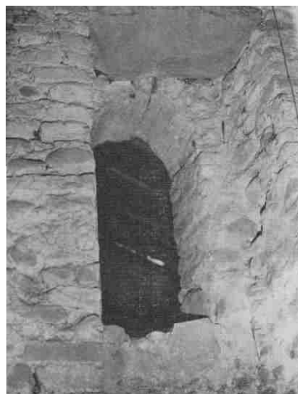
Fig. 17 Vano di accesso alla torre originaria - da Favini in "Antichi monumenti plumbiensi, San Vincenzo in Castro, estr. B.S.P.N., anno 1973
